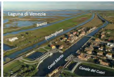
Foto aerea fiumi Brenta Bacchiglione e Canal Moro Chioggia (Venezia)
