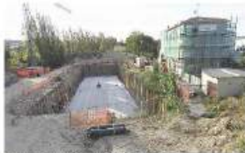
Lo scavo per la vasca di prima pioggia alla foce dell'Arzilla
