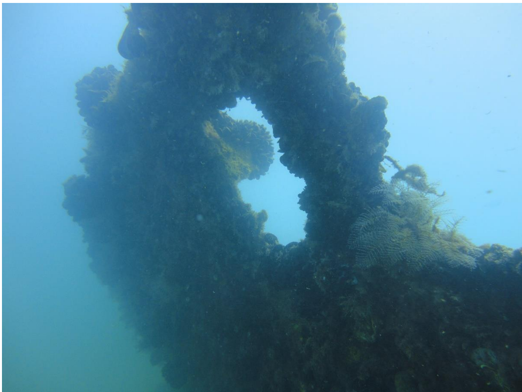
Figura 178: Parete esterna dello scafo;
