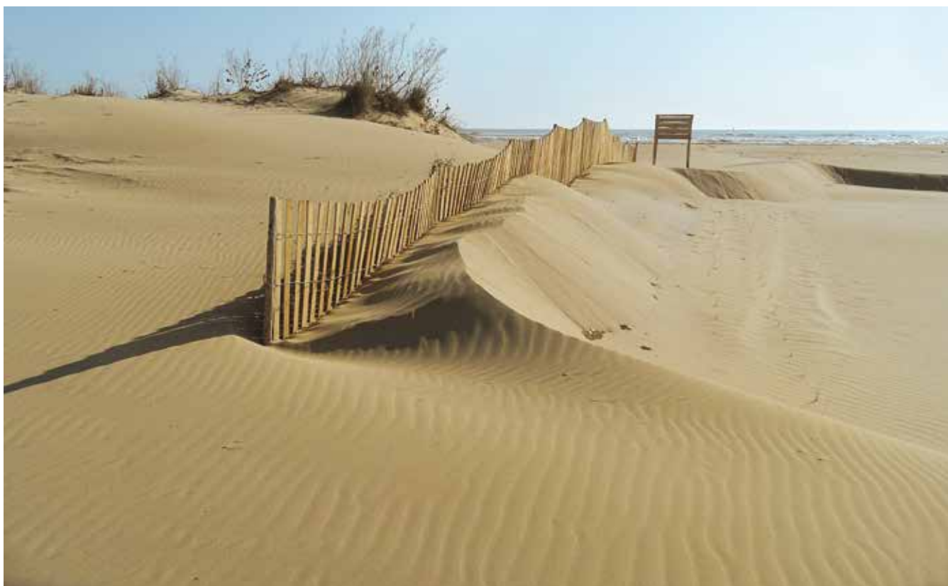
Figura 1. Accumulo di sabbia sui frangivento dopo alcuni mesi dall'installazione (foto Consorzio Venezia Nuova - Agriteco)
