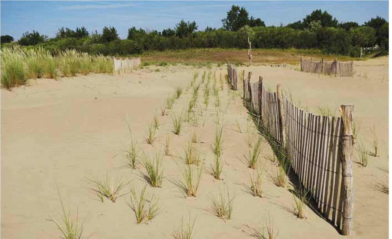
Figura 2. Moduli di frangivento e trapianto di ammofila (foto Consorzio Venezia Nuova - Agriteco)
