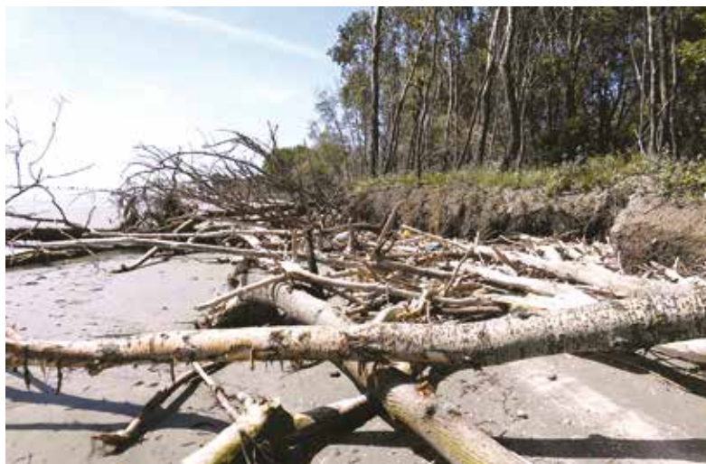
Figura 11. Erosione del margine della cassa di colmata B. Nell'immagine sono visibili un fronte di crollo e i livelli sabbiosi alla base dei depositi di materiale (limo-argilla) refluito dai mezzi di dragaggio per la realizzazione della colmata
