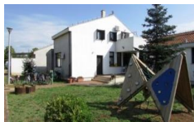
Kindergarten 'Tičići' Novigrad
