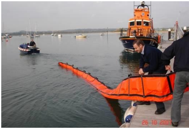
Figura 2: una panna rigida viene dispiegato dalla costa Figura 3: una panna rigida in mare
