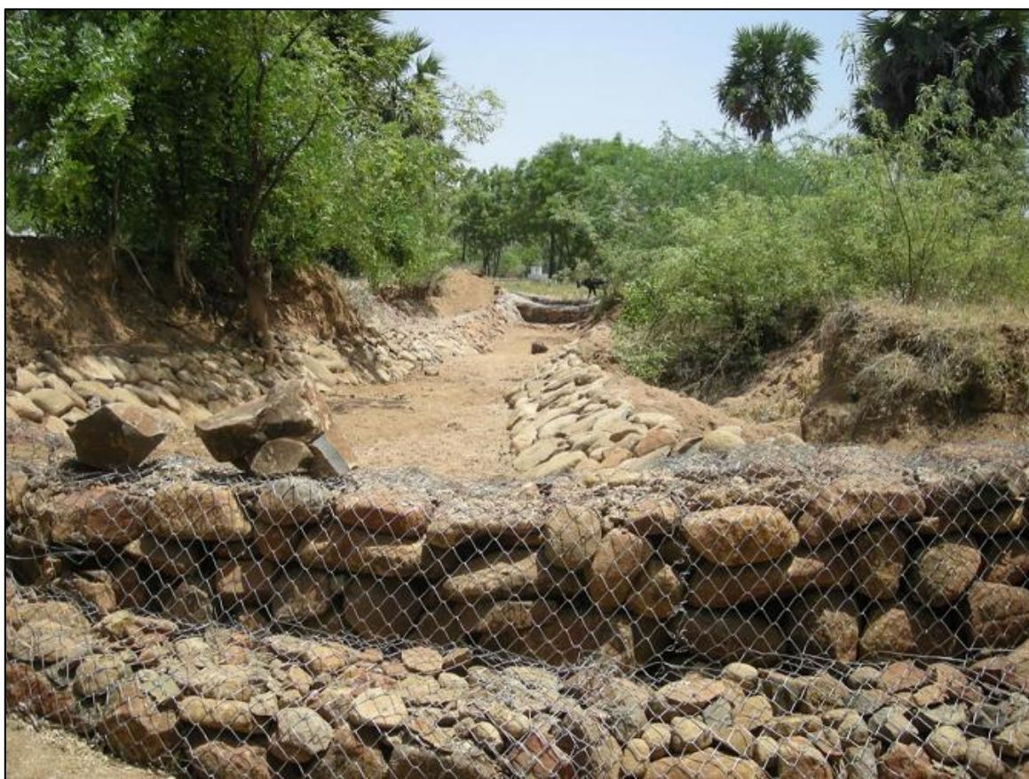
Slika I-61. Primjer erozijske brane izgrađene od gabion ograde u dnu jaruge
