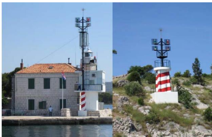
Slika VIII-30 Semafofska svjetla na izlazu i ulazu kanala (lokacija Jadrija i Martinska)
