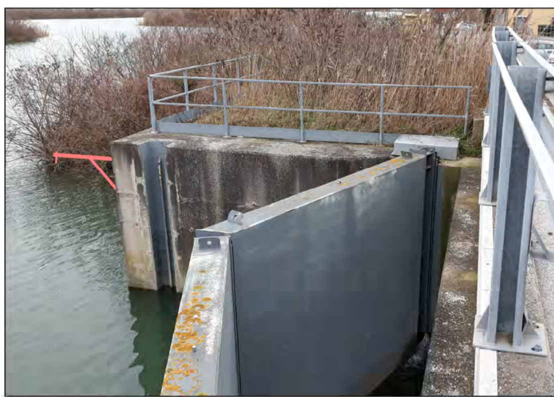
FOTO N.1 - Insetimento del sensore di livello prospetto di valle
