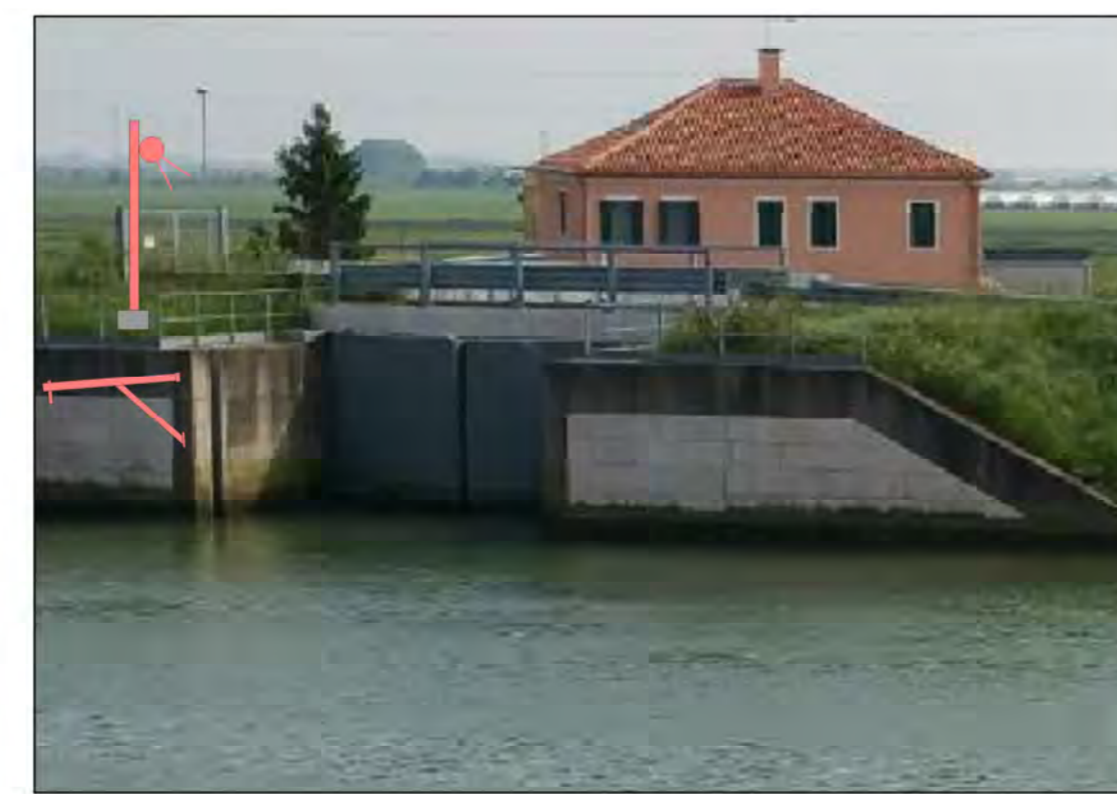
FOTO N.2 - Insetimento del sensore di livello e palo per web-cam prospetto di valle
