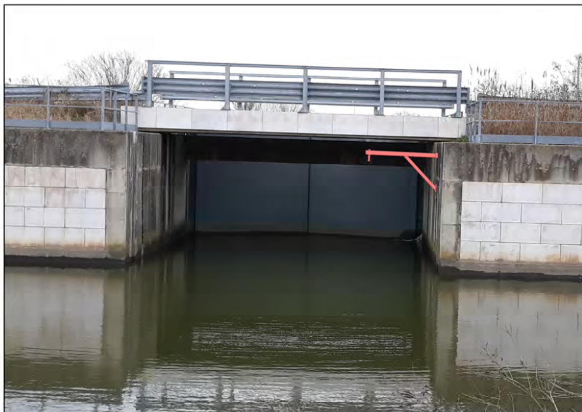
Foto 1: Inserimento della staffa con sensore di livello nel prospetto di monte.-
