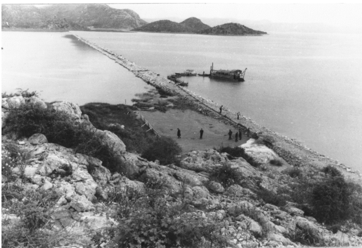
SLIKA 1. FOTOGRAFIJA NA PODRUČJE OBALNOG NASIPA DIGA PRI IZGRADNJI
