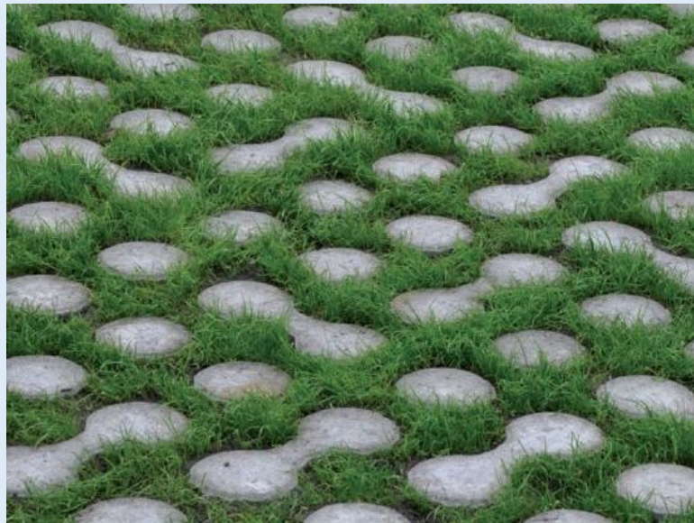
Esempio di pavimentazione permeabile ad uso residenziale, pedonale o parcheggio
