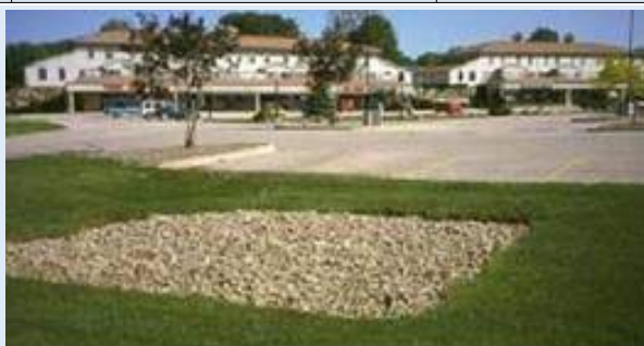
Esempio di trincea infiltrante applicata in prossimità di parcheggio e area residenziale
