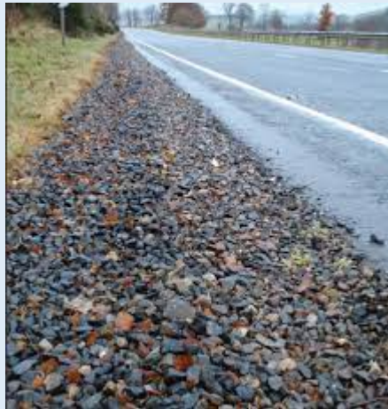
Esempio di dreni filtranti Progetto LIFE Derris
