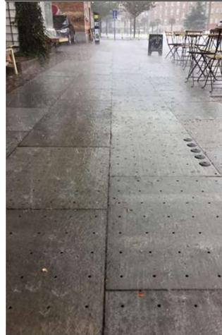
Progettata per consentire all'acqua piovana di infiltrarsi attraverso la superficie, o negli strati sottostanti, per essere rilasciata a una velocità controllata.
