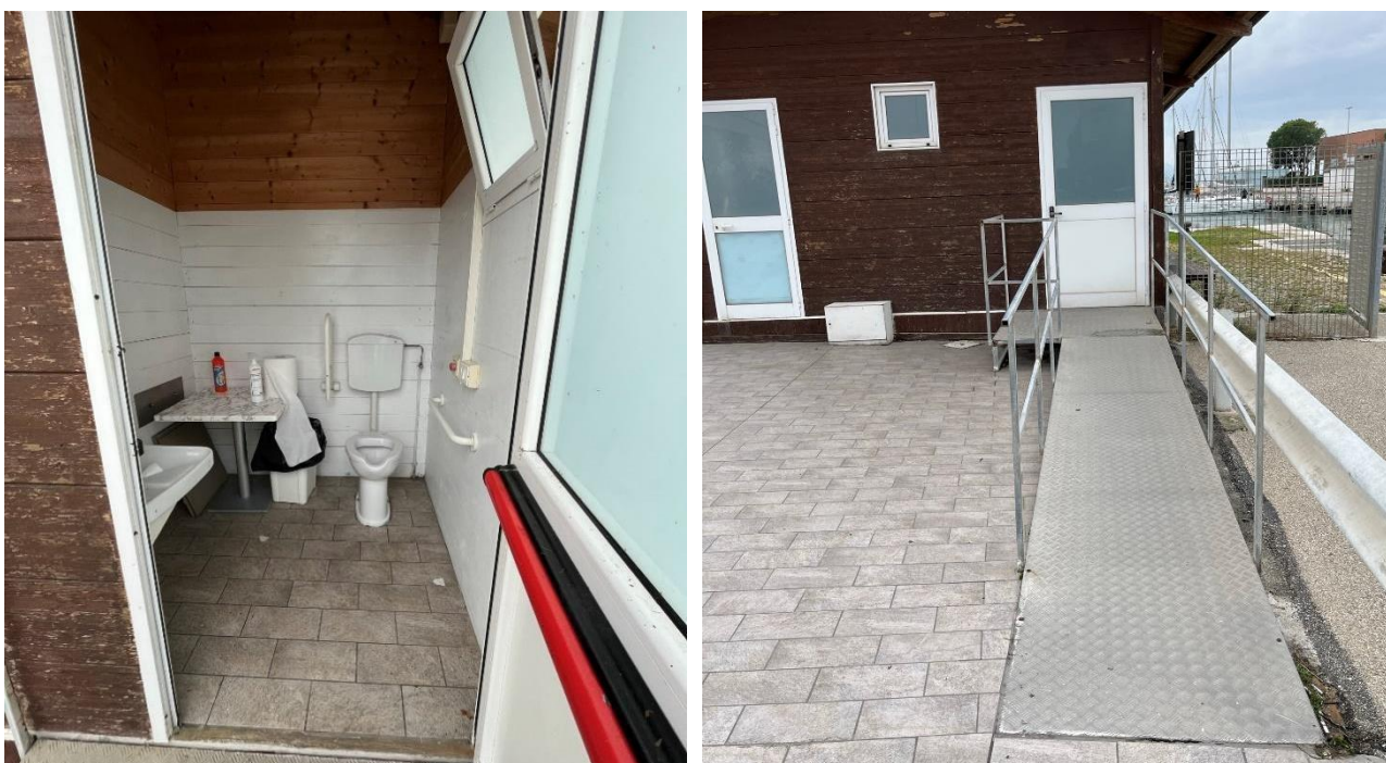
Figura 5-9: Servizio igienico accessibile con rampa
