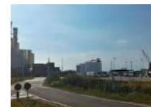
Il deposito Gnl
