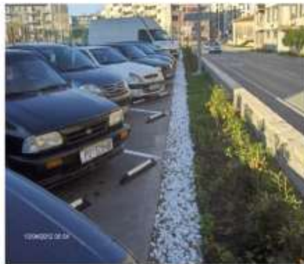
Slika 4.9.5. Infiltracijski jarci parkirališta Dom Braće Ribar Pula
