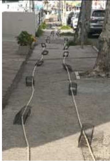
Figura 6. Realizzazione dei long line
